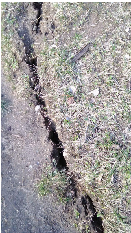
Trijų kryžių kalne formuojasi nuošliauža | Deivydo Jonelio nuotr.
